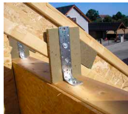
Kotvení krokve na pozednici – osedlání boční příložkou
