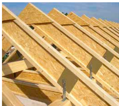
Schéma kotvení – příložka z druhé strany I-nosníku
