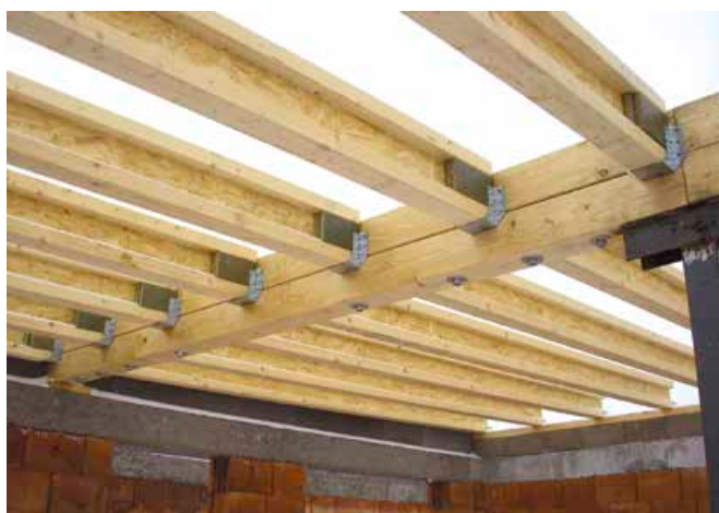
Použití kovových třmenů pro výměnu nebo strop
